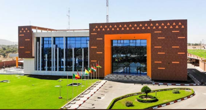
Vue de la nouvelle Agence Auxiliaire de la BCEAO à Kayes
